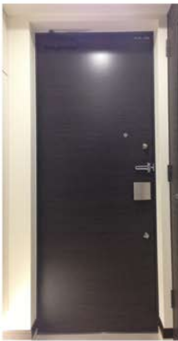
(2) 室内側からみたドア全体の写真
